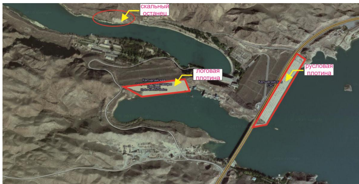
Рисунок 1 – Космический снимок гидротехнических сооружений Капчагайской ГЭС
